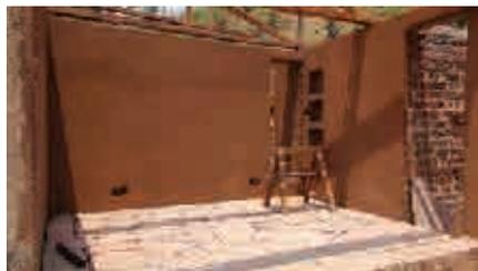
Weiterbau konnte sofort begonnen werden. Fertigestellen waren der Steinfußboden, die Holzterrasse, die Fenster und Türen, die Grube für das Grauwasser und das Badezimmer mit der Grauwasserentwässerung sowie die Einrichtung.
